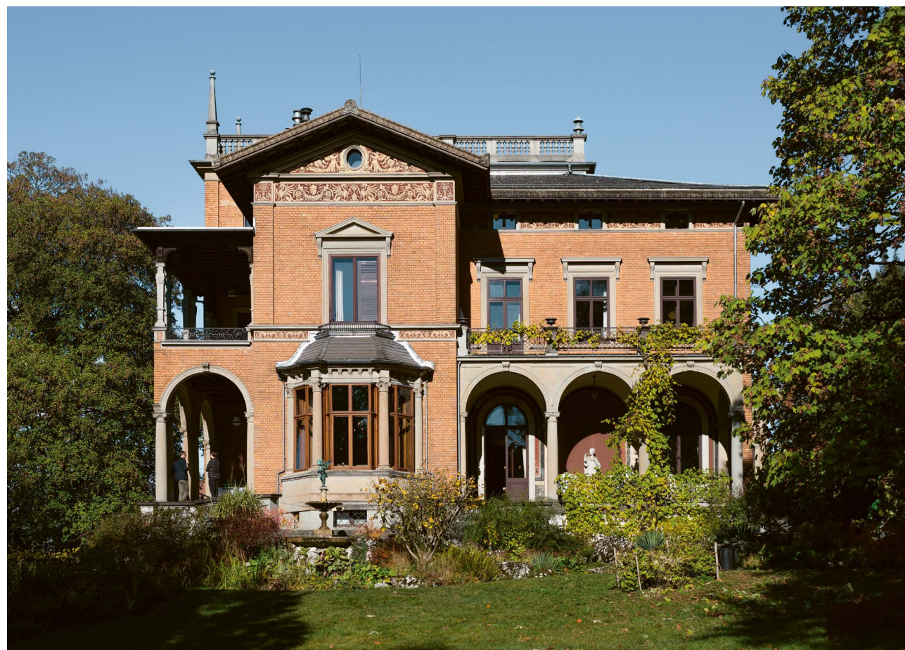
ILL. 1 Façade principale de la Villa Bleuler, vue du sud-est; à droite, les trois arcades de la loggia du grand salon
